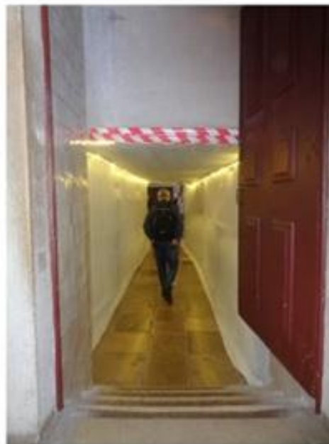
Figura C-1 – Reabilitação dos revestimentos interiores da cozinha do Palácio Nacional de Sintra
