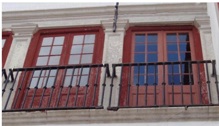
Figura 5.2 – Exemplo de caixilharia sem intervenção recente (esquerda) e com sinais de intervenção recente (direita)
